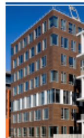
Projet : Bureaux Alstom C3 Lieu : Saint-Ouen (93) Architecte : Reichen & Robert & Ass.
