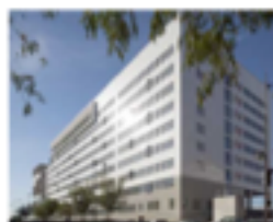
Projet : Université Diderot MGA1 Lieu : Paris Architecte : JB Lacoudre Architecte
