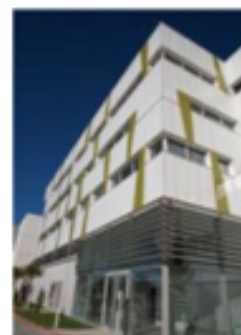
Projet : Bureau Fahrenheit Lieu : Montpellier Architecte : Philippe Cervantes
