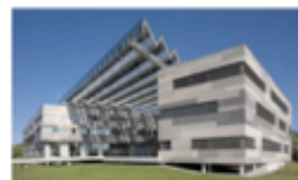
Projet : Site administratif du crédit agricole Lieu : Aurillac Architecte : AFAA
