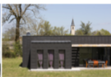
Maison individuelle Roussennac CL Architecture
