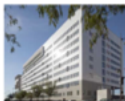
Projet : Université Diderot M6A1 Lieu : Paris Architecte : JB Lacoudre Architecte
