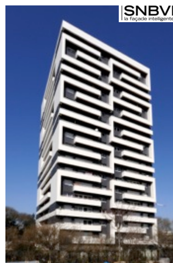
Une rénovation thermique et esthétique réussie pour la Résidence CURIAL, Paris 19. MO : Paris Habitat MOe : Cabinet ARCANÉ Photo : DR
