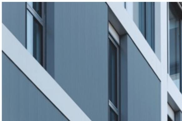
L'un des premiers défis à relever par l'Atelier Cambium est de trouver une solution à coûts maîtrisés, respectueuse de la Règlementation Thermique de 2012 et affichant une performance d'affaiblissement acoustique de 42 dB, en adéquation avec le confort sonore imposé pour les futurs logements. Le second objectif porte sur la réalisation de ce chantier en filière sèche.
