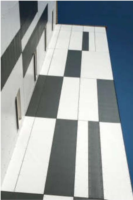
La mise en œuvre des 17,000 m<sup>2</sup> de panneaux de façade HardiePanel® en pose verticale sur ossature bois et laine de roche, a été assurée par les 45 compagnons des équipes NorPac.
