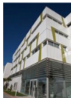
Projet : Bureau Fahrenheit Lieu : Montpellier Architecte : Philippe Cervantes
