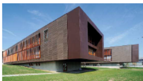
Projet : Lycée Germaine Tillion Lieu : Sain-Bel (69) Architecte : Atelier Arche
