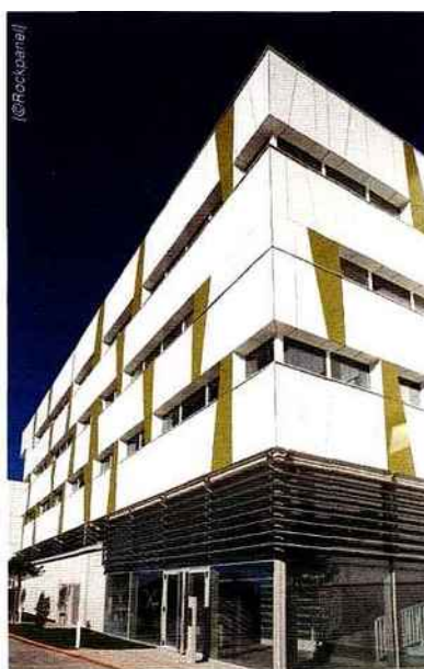
Bureaux Fahrenheit à Montpellier (34), bardage Rockpanel, architecte Philippe Cervantes.
