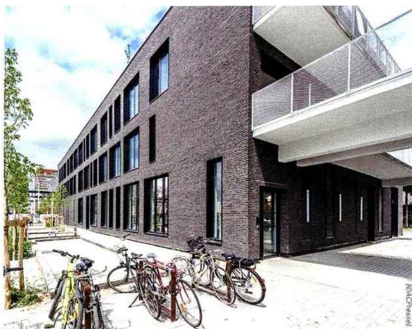
Opération #Unik, à Nantes. Sandra Planchez, architecte. Cet ensemble regroupant logements, bureaux et commerces reçoit une façade ventilée, intégrant un doublage en briques sombres signées Wienerberger, complété sur certaines zones, par un bardage métallique.
