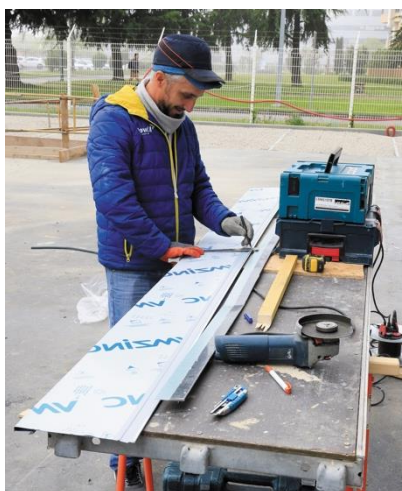
Mise en œuvre du Clin VMZINC®
