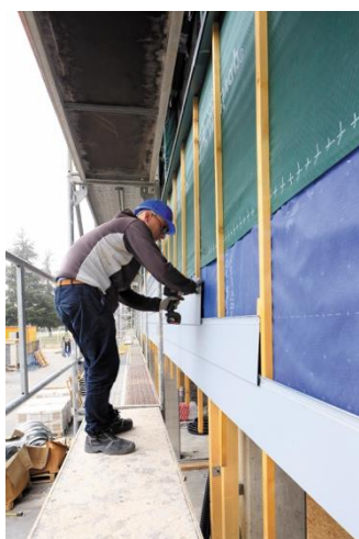
Mise en œuvre du Clin VMZINC®
